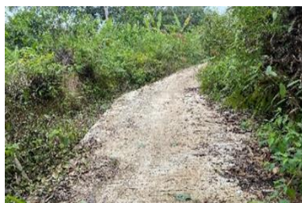
Gambar 2. Kondisi Jalan tani Setelah Pembangunan
